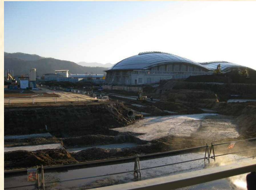
掘削状況 （H26.1）
