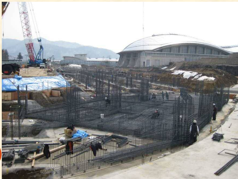
配筋組立状況（H26.3）
