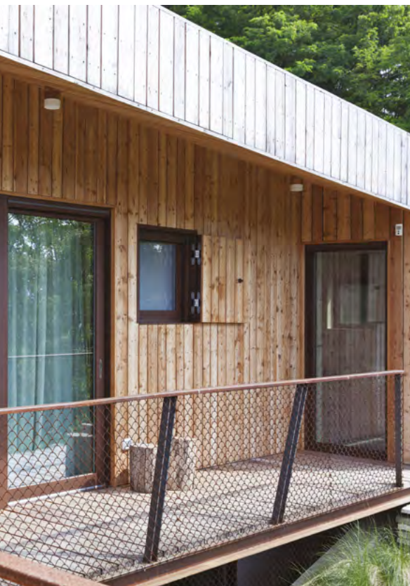
Installation de détecteurs à l'extérieur
