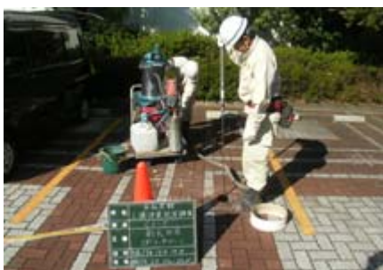
土壤汚染調査
