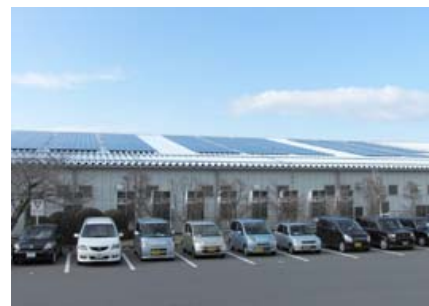
滋賀工場に設置されている太陽光パネル
