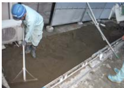
埋め戻し作業
