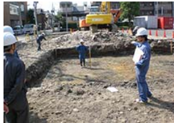
汚染土の掘削除去
