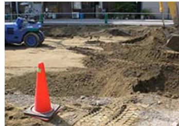
清浄土による埋め戻し作業
