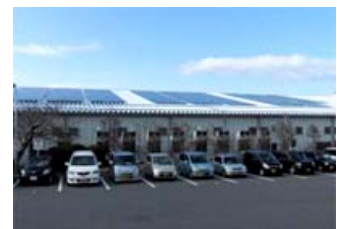
太陽光パネルは、国道307号線に面したC棟の屋根に1,020枚敷き詰められました。
