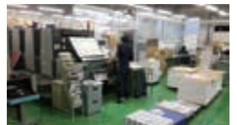
全面再塗装を行った床面
