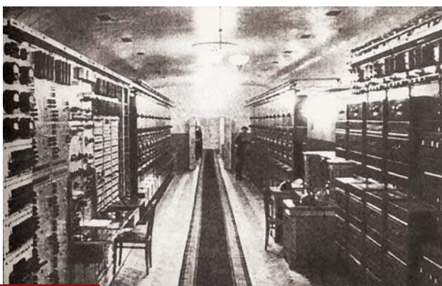
Московская станция ВЧ-связи.
