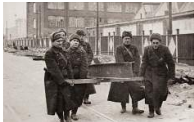
Военнослужащие Полка специального назначения УКМК НКВД СССР на строительстве оборонительных сооружений.
