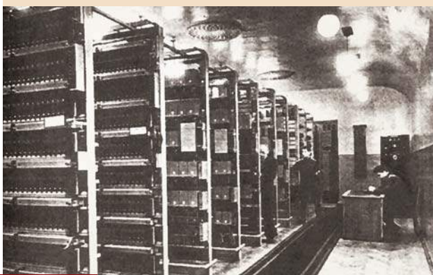
Московская станция ВЧ-связи.
