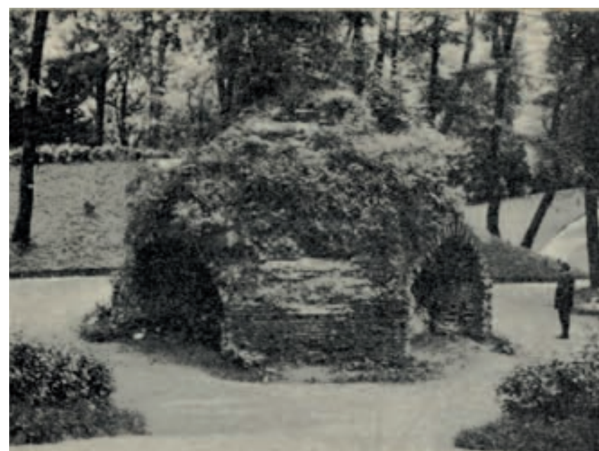
Podwaliny kościoła Opatrzności Bożej w Ogrodzie Botanicznym, ok. 1906; APW
