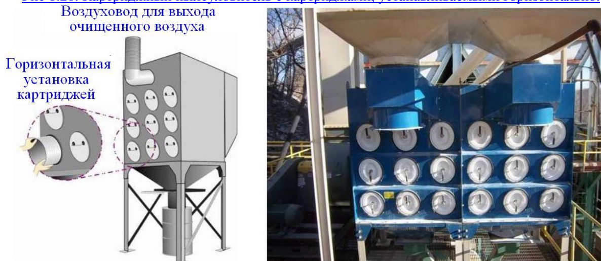
Рис 1.20. Картриджный пылеуловитель с картриджами, устанавливаемыми горизонтально.
