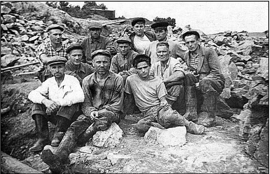
На будівництві мосту.
