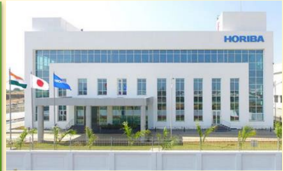
HORIBA India Private Limited (Pune)
