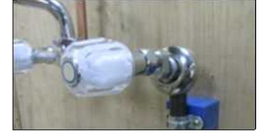
<냉수관 설치 사진>
