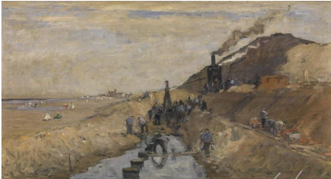
fig 54. Richard Baseleer, Dijkbouw aan het strand in Knokke (1909)
