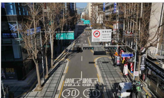
〈공사 시행 전〉
