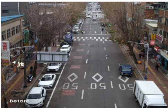
〈공사 시행 전〉
