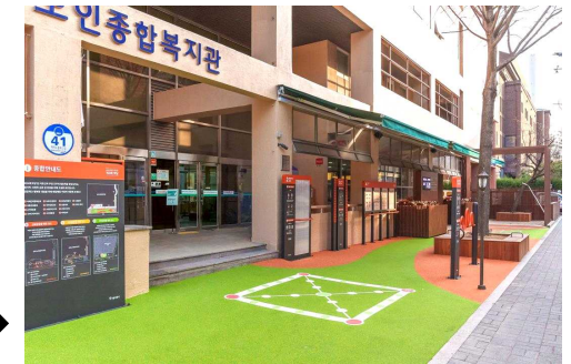
<조성 후> 100세 마당 전경
